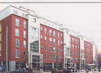
**Sophienhof u Frankfurtu od 2006. godine je najveća pasivna kuća u Njemačkoj. Ta gotovo samodovoljna stambena zgrada ima 160 stanova s odličnim komforom i zdravom mikroklimom koju podržava stalni dovod zraka kroz kolektore u tlu.**
