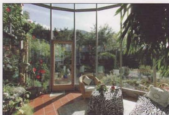
**Kiralyeva solarna pasivna kuća sa staklenom južnom fasadom i sustavom zračnih podzemnih kolektora ostvarila je tijekom godina sva očekivanja. Trostruko ostakljenje velikih ploha uspješno je čuva od vanjskih utjecaja, podjednako ljeti i zimi.**
