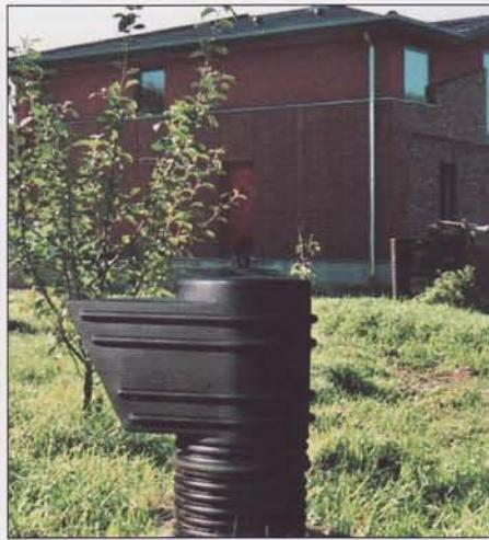
... pa kontrola i izmjena filtra ne zahtjeva više od nekoliko minuta. Brzina zraka u cijevima uglavnom je oko 1 m u sekundi.
